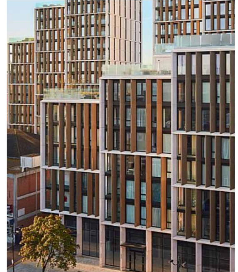
METAL FINNS + SOFFIT
