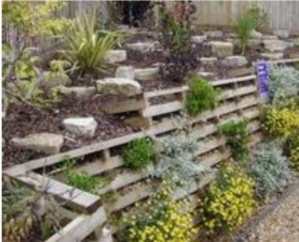
**Fig. 19 – Sample Crib Wall**
