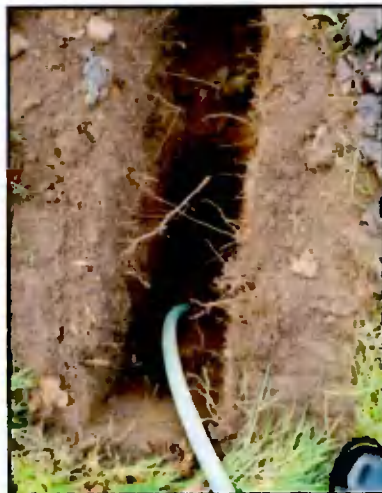
BRE 365 TEST HOLE
